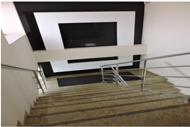
Klatka schodowa do lokalu
